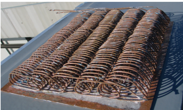
Figure 4. Structure of roof PHP 图 4. 屋顶脉动热管结构
