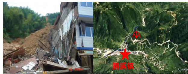
图2. 彭溪滑坡受损房屋滑坡点遥感影像图
