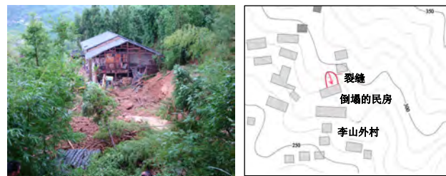
图1. 李山外滑坡受损房屋及滑坡点地形图
