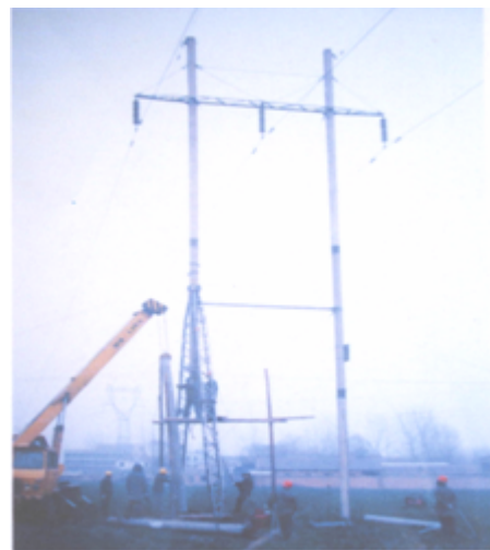
figure1. Panorama of replacing concrete pole 图 1 更换砼杆下节全景图
