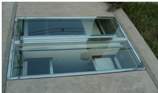
图 2 防火隔板使用角铁连接并固定 figure2. Fire partitions to connect and use the angle iron fixed
