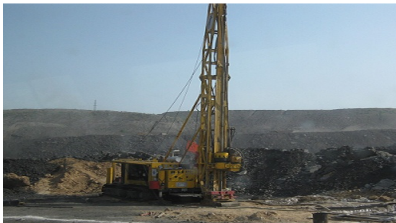
图2 露天矿煤田火灾钻孔温度监测现场
